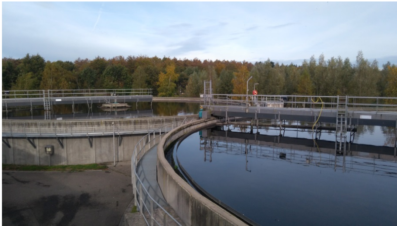
Afbeelding 2.3. Nabezinktanks van een RWZI (Bron: RIVM)
