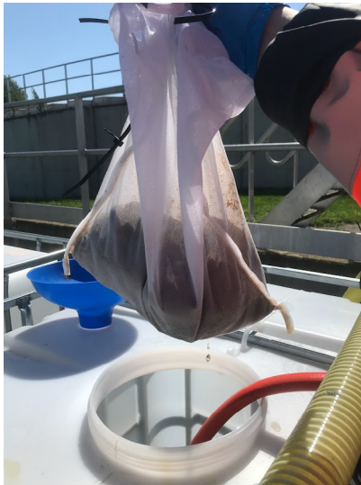
AFBEELDING 4.10 HET UITGESPOELDE DEXSORB TIJDENS REGENERATIE WERD AFGEVANGEN IN EEN ZAK ZODAT DIT LATER WEER AAN HET FILTER KON WORDEN TOEGEVOEGD
